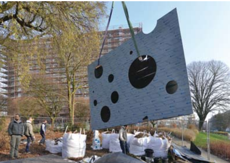
VUE DE MONTAGE DE L'UNE DES QUATRE TÔLES DE PAS À PAS #03, DÉCEMBRE 2016, QUARTIER FLORAIR, JETTE / BRUXELLES (Ph. MARC DEFITTE, SLRB)
